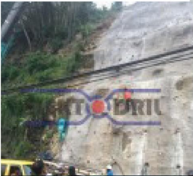
Pembuatan rock bolt, rock drill, Sindanglaya - Cipanas, Bogor
