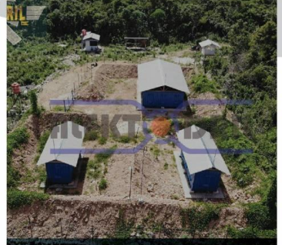
Pembangunan Gudang Handak dan Drilling Blasting Buton, Sulawesi Tenggara
