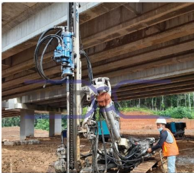
Pembuatan Lubang Tiang Pancang Perkuatan Tol Pekanbaru
