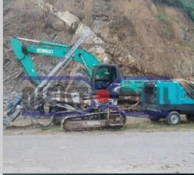
Proyek Konstruksi Palu Sulawesi Tengah
