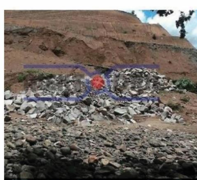
Drilling Blasting Micro Hydro, Pembangkit Listrik Tenaga Air, Gununghalu, Bandung
