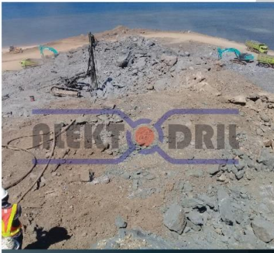
Drilling Blasting Tambang kab. Lima Puluh Kota, Sumatera Utara
