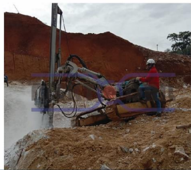
Drilling Batu Kapur Pekanbaru - Riau
