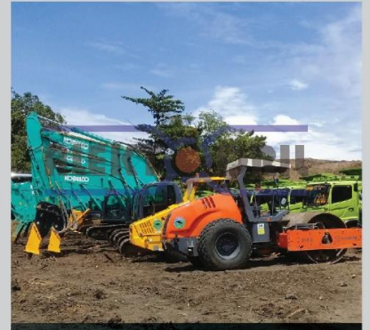
Cut & Fill PLTU Gorontalo
