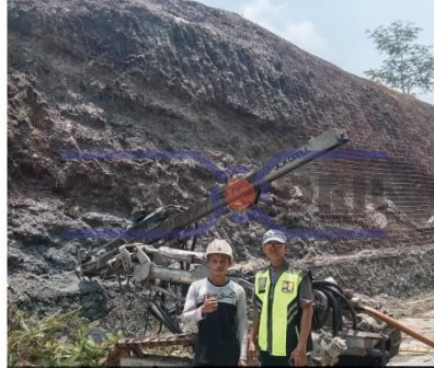
Pekerjaan Rock Bolt Jasinga, Bogor
