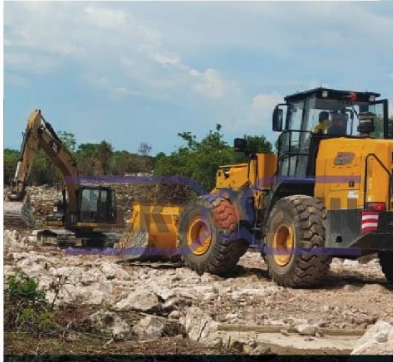
Land Clearing Buton - Sulawesi Tenggara
