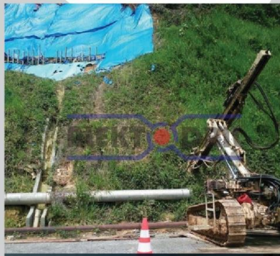
Pekerjaan rock drill Tarutung, Medan
